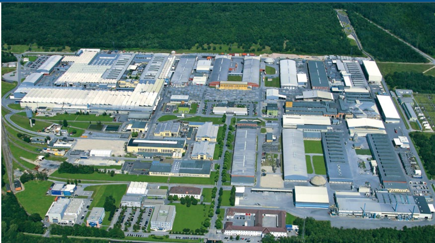
AMAG – Ranshofen – der integrierte Standort für spezialisierte und innovative Lösungen
